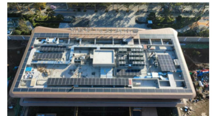
中建西安公司中建悦庐幸福序营销中心屋顶光伏发电项目
