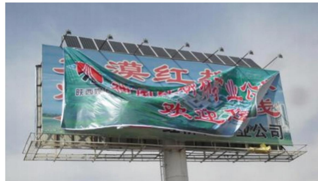
户外广告牌太阳能发电（陕煤化）
