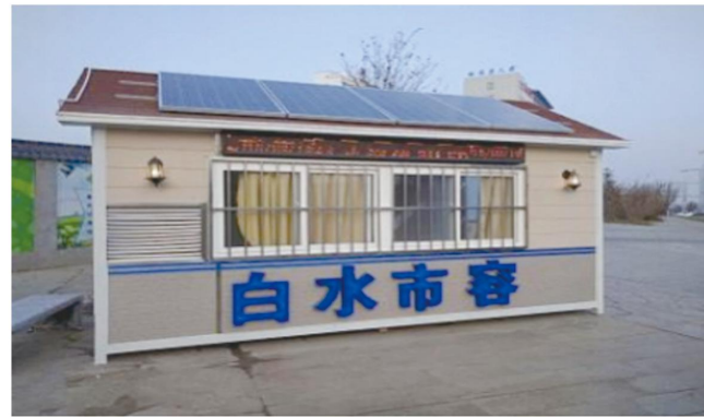
渭南环卫休息亭光伏离网电源
