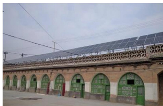
吴堡县村级光伏扶贫电站
