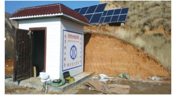
光伏水泵应用-神木贺家川镇光伏饮水工程
