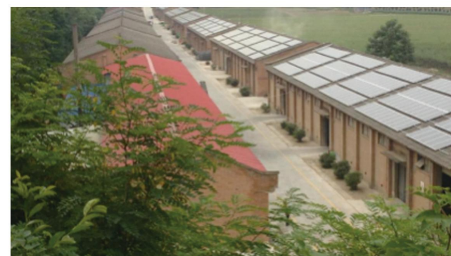
杨凌天和厂房屋顶光伏并网发电系统（老式坡屋顶）
