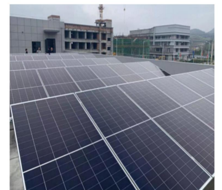
甘肃徽县农业产业园新建检测楼屋顶光伏发电项目
