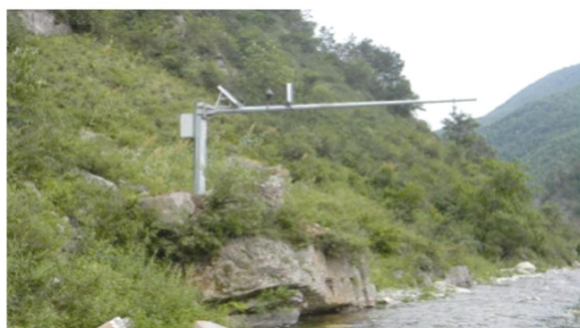
水位、雨量、泥沙自动监测太阳能电源
